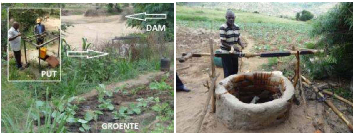
Een aantal boeren hebben zelf een stenen afsluitbare waterput gemaakt nabij de dam om water makkelijker en sneller uit de zandbedding te onttrekken voor irrigatie doeleinden.
